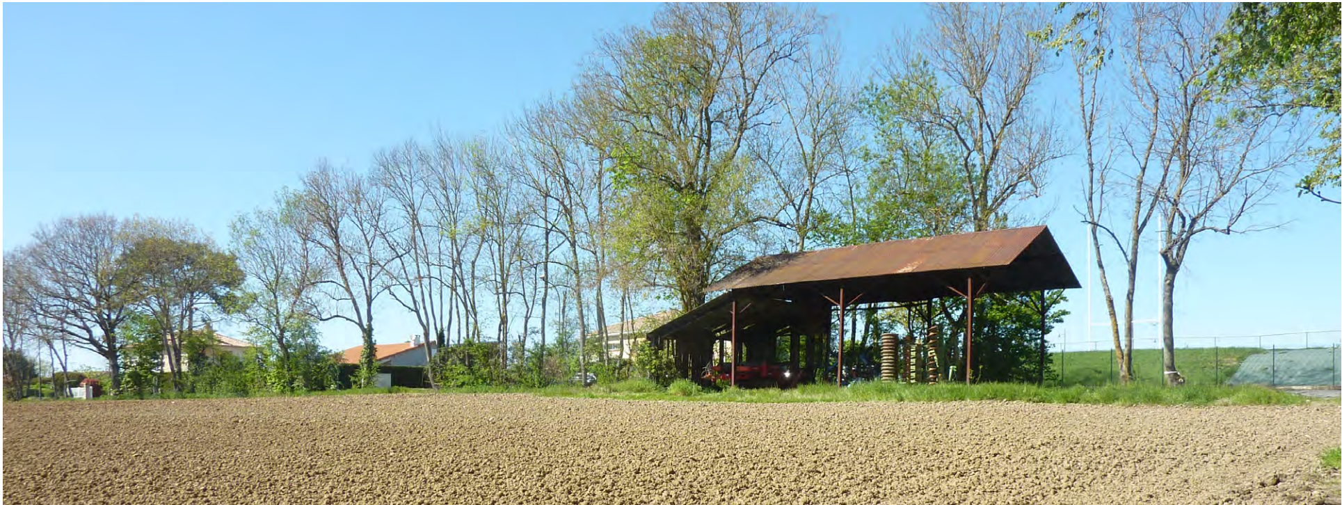
4. Vue sur le hangar Agricole qui sera déconstruit
