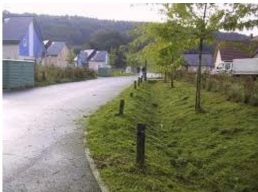
Sauf cas spécifiques liés à des obligations d'aménagement (création d'ouvrages d'accès aux propriétés, nécessités de stabilisation de berges, incompatibilité de l'infiltration ...), la couverture et le busage de fossés, noues, canaux ou cours d'eau sont proscrits ainsi que leur bétonnage.
