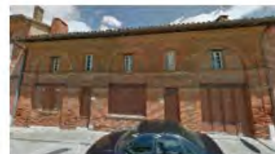
Maison de brique du 22 rue du Mur de Ronde
