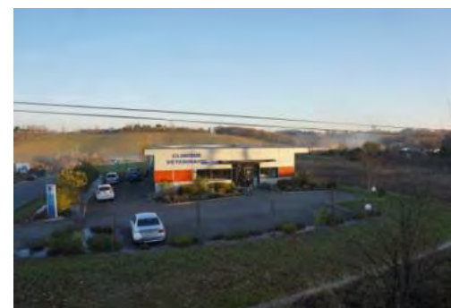
Figure 27: Zone d'activités de l'Ormière
