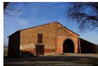
Bâtiment agricole lieu-dit Château St- Joseph
